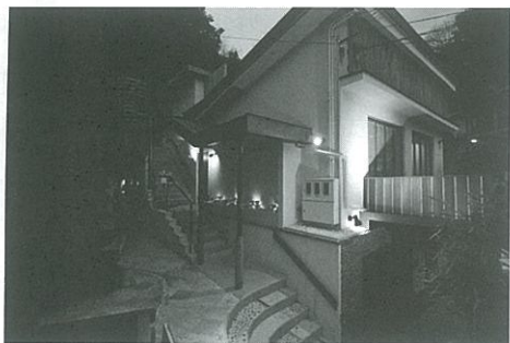
旅館樋口に隣接して設けた「有福Cafe」。カフェ機能に加えて、貸切露天風呂6ヵ所も増設。宿泊施設として別邸「天照」(1室)も備える。
